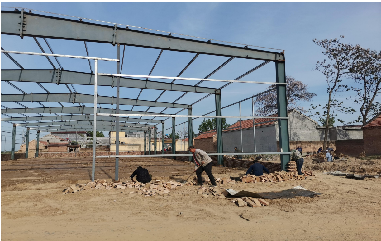
3. 郭寨村扶贫车间项目施工。
